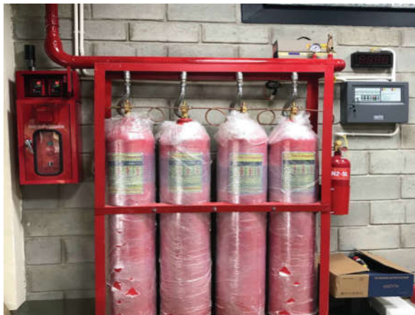
Hệ thống khí được lắp đặt hoàn thiện
