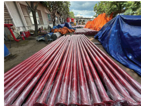
Đường ống lắp ráp cho công trình
