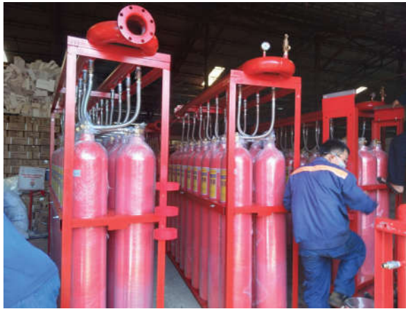
Công nhân đang lắp đặt hệ thống khí
